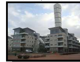
Osiedle niskoenergetyczne w Malmö (Szwecja), 2011.11.10
